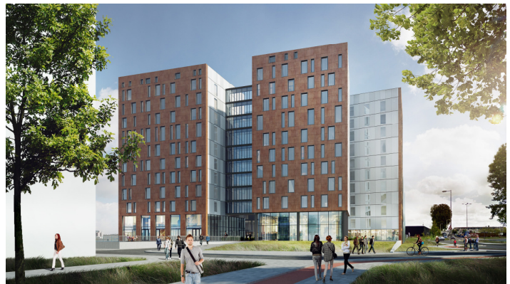
Beeld Amsterdam City Harbour Hotel gezien vanuit het westen
